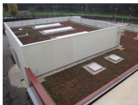
Toiture terrasse stockante
