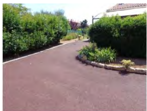
Allée/parking en enrobé poreux (source : Celtivia)
