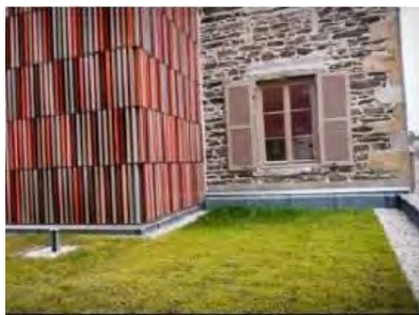
Toiture végétalisée (source : Grand Lyon)
