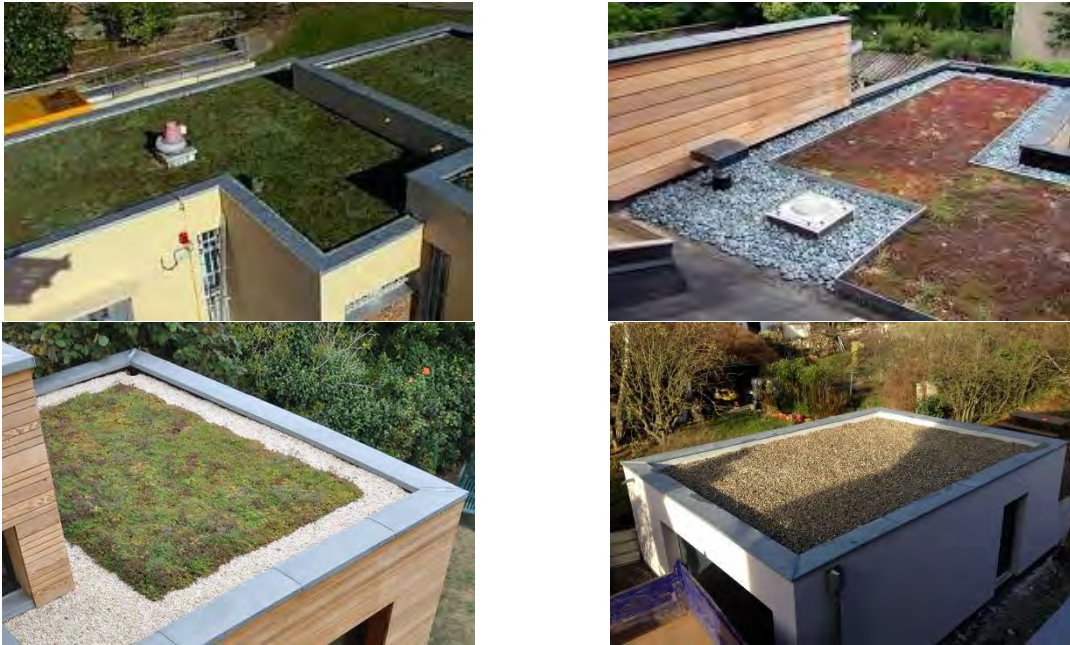
Exemples de toitures stockantes (végétalisées ou non)
