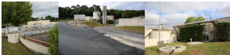
Travaux de la STEP de Saint-Georges-de-Didonne.
