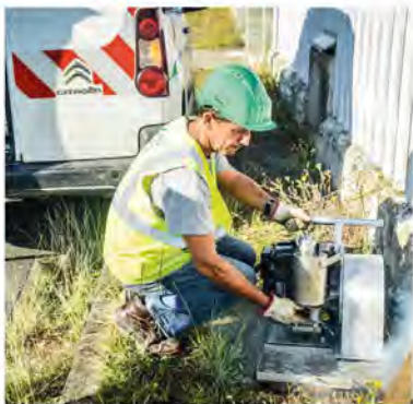
Tout "à la fumée" pour la vérification des réseaux.
