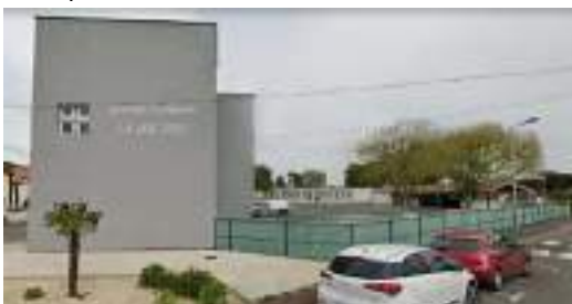
Groupe scolaire La Sablière
